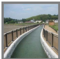
三面コンクリート水路への変換
